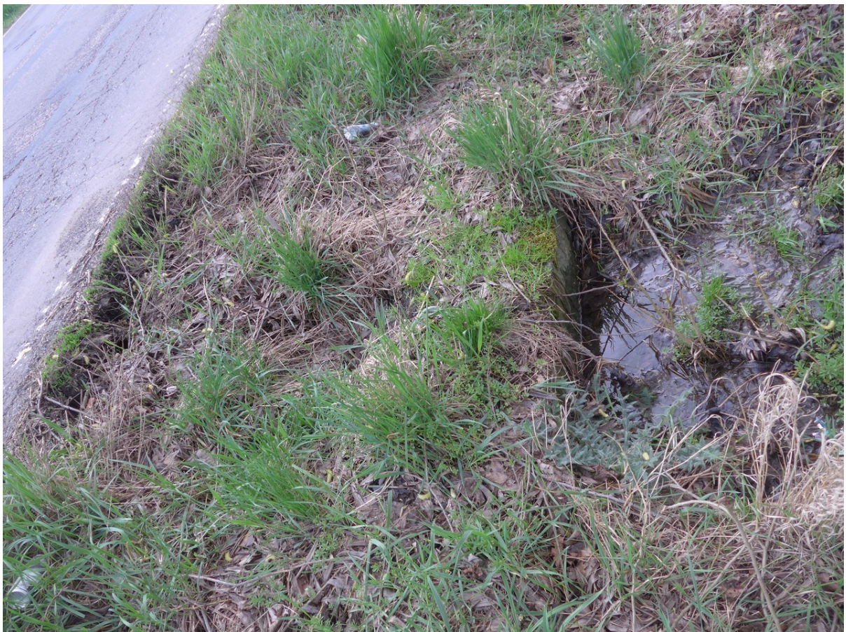
Pohled na nefunkční propustek, který by měl být upraven do podoby umožňující migraci živočichů
